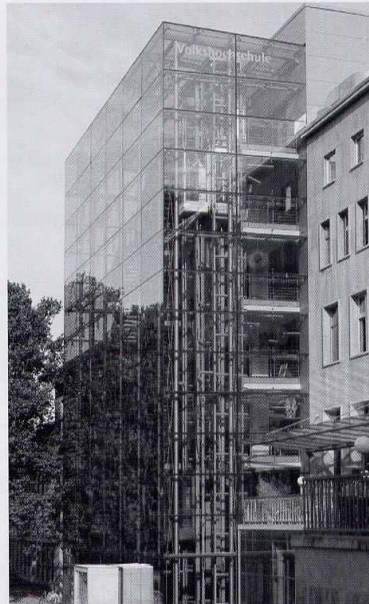
Nicht nur außen ein modernes Haus: die VHS Essen
